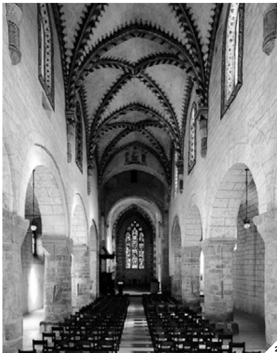
Vue de la nef en direction du chœur : 1/ état avant restauration 2/ état actuel après restauration
