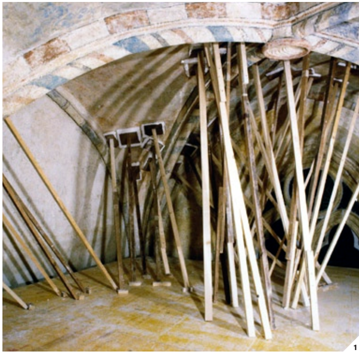
Chapelle sud: 1/ Consolidation des supports
